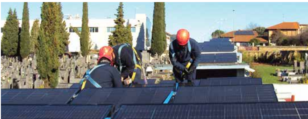
La actuación se ha llevado a cabo en la cubierta de diez edificios destinados a nichos y en el tejado a dos aguas del edificio de vestuarios del personal del propio Cementerio.
