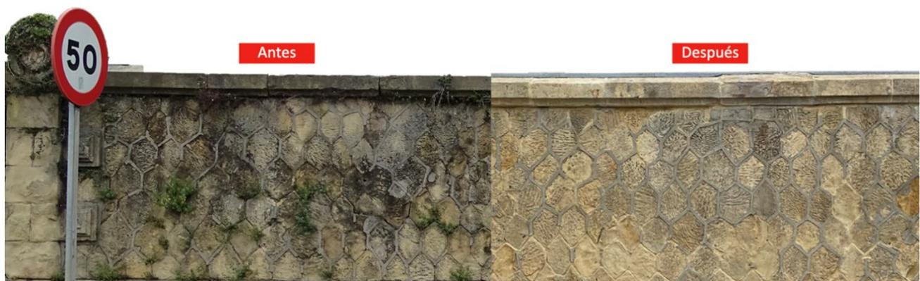
La intervención comenzó con la retirada, de manera manual, ayudadas con escalpelo, pinzas y alicates, de toda la vegetación posible. Se empezó desde la entrada y se continuó hasta la zona más al oeste del muro. En zonas más concretas se aplicó biocida para debilitar un poco la raíz y así poder extraerla con mayor facilidad.
